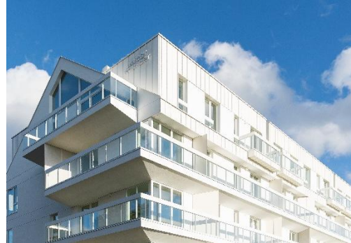
fol. budynek o numerze administracyjnym nr 77 widziany od strony ul. Wita Stwosza, ujęcie w kierunku dzielnicy Wrzeszcz
