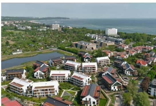
fot. widok z lotu ptaka
